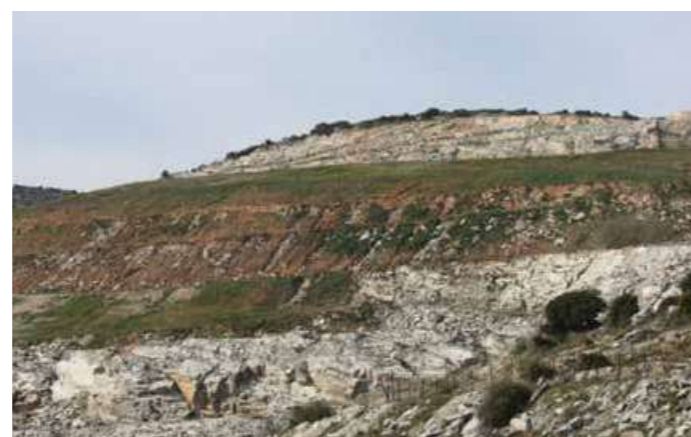
Εικόνα των πρηνών στο λατομείο σχιστόλιθου Αρκουδορέματος μετά την εφαρμογή της υδροσποράς
